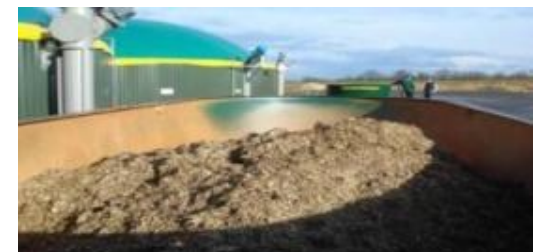
Landwirtschaftliche Biogasanlage in Bischheim, Rheinland-Pfalz
